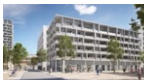
WORK #2 2 264 m 2 de bureaux Confluence
