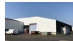
PERRIER CONSTRUCTEUR 1 320 m 2 Grand Lyon Nord Est
