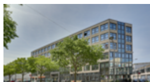
120 JEAN JAURÈS 3 600 m 2 de bureaux Gerland
